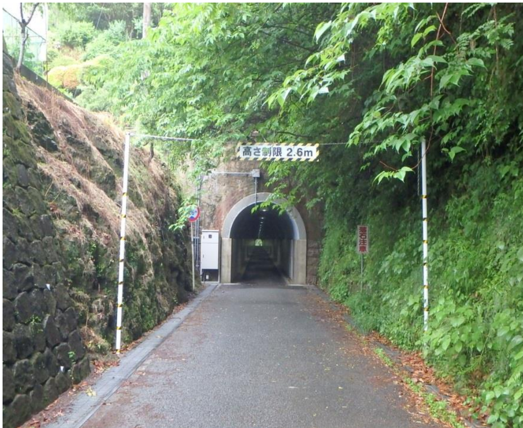
河内トンネル
