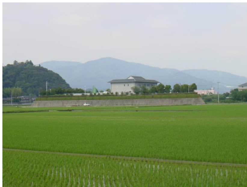
肱南浄化センター
