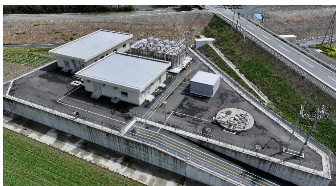
大洲市上水道 菅田浄水場
