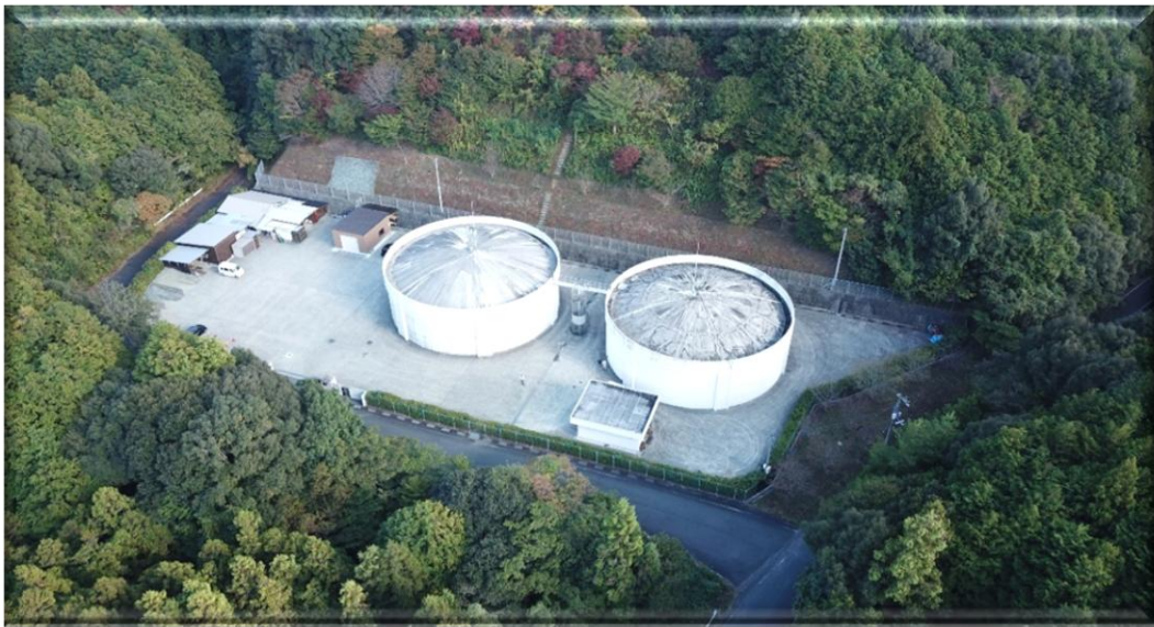
大洲市上水道 五郎配水池
