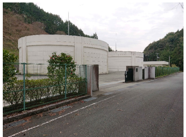
大洲市上水道 五郎配水池
