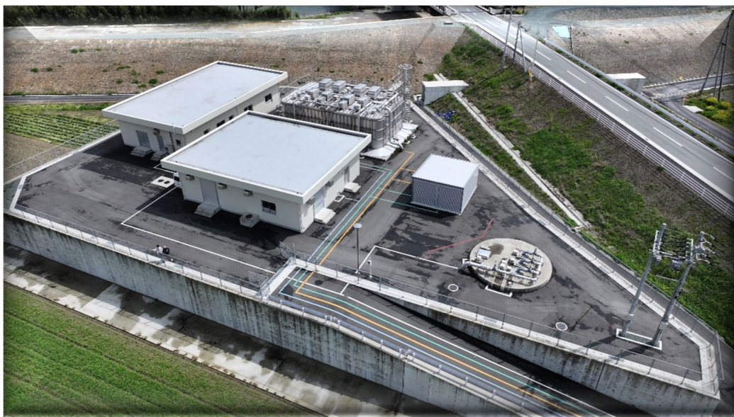
大洲市上水道 菅田浄水場
