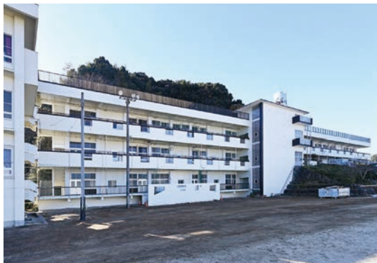
長寿命化工事が完了した大洲南中学校校舎
