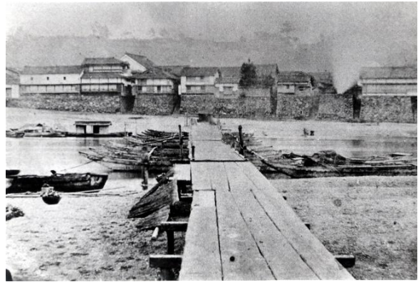
肱川に初めて架けられた橋 浮亀橋
