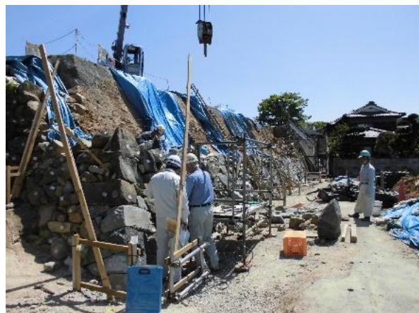
大洲城の石垣改修工事の様子
