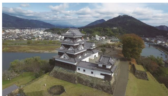
大洲城（台所櫓・高欄櫓・天守）
