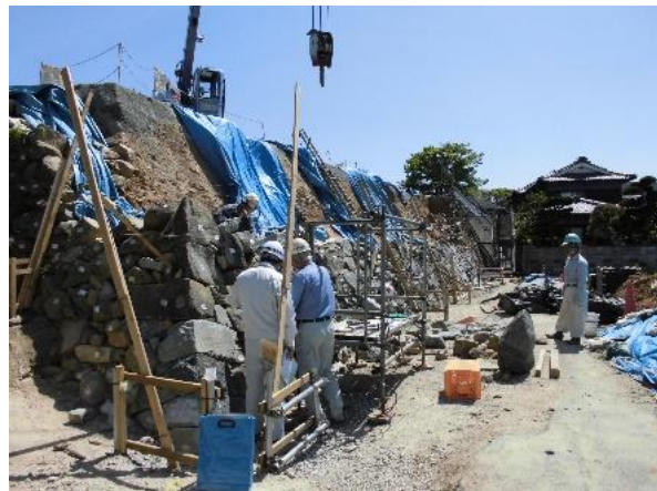
大洲城の石垣改修工事の様子
