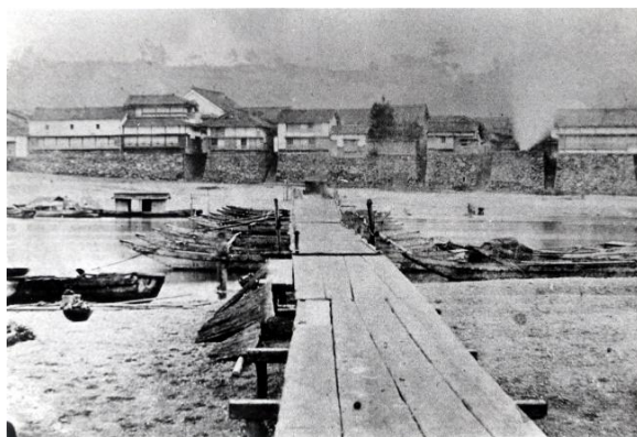
肱川に初めて架けられた橋 浮亀橋
