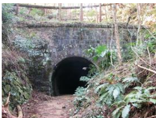
切石と煉瓦造りの河内トンネル
