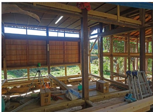
古学堂跡学室保存修理の様子 (令和6年4月10日)
