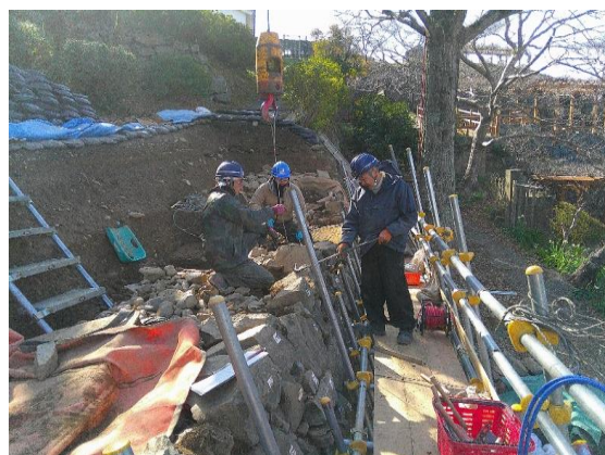
石垣D-1箇所の石垣解体の様子 (令和7年1月30日)
