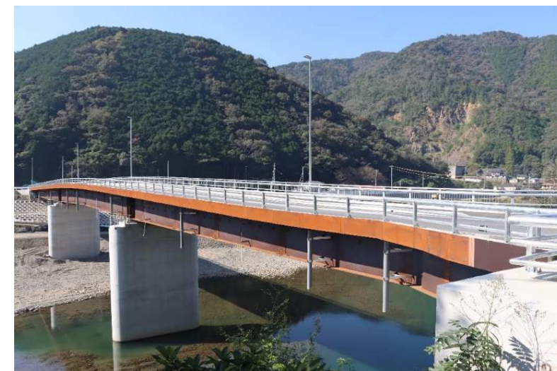
市債等を活用して完成した 市道貫小屋線「父橋」
