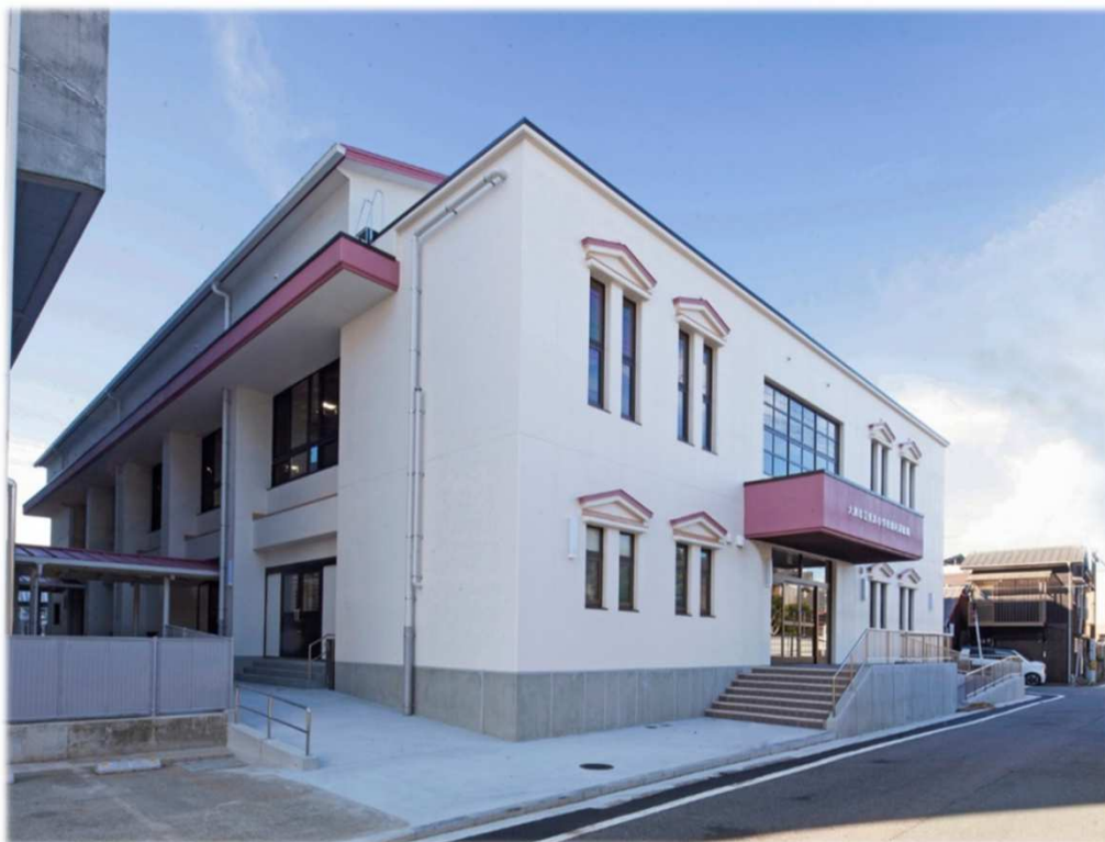
長浜小学校屋内運動場改築事業
