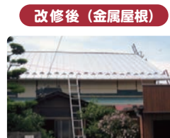
改修後（金属屋根）
