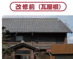
改修前（瓦屋根）
