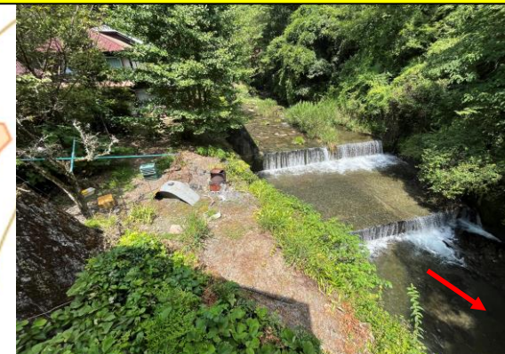
取水候補地（落差工） コアングラスクリーンの設置を想定 落差工の右岸は民家
