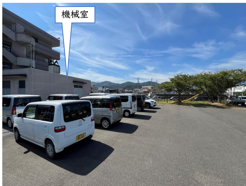
図 機械室周辺
