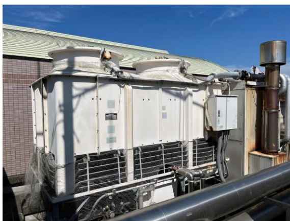
図 吸収式冷温水機 外観
