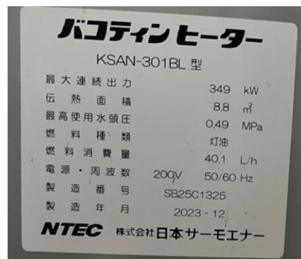
図 ボイラー銘板
