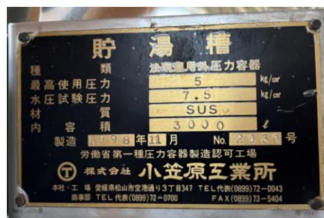
図 貯湯槽銘板
