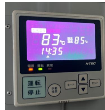
図 ボイラー設定温度
