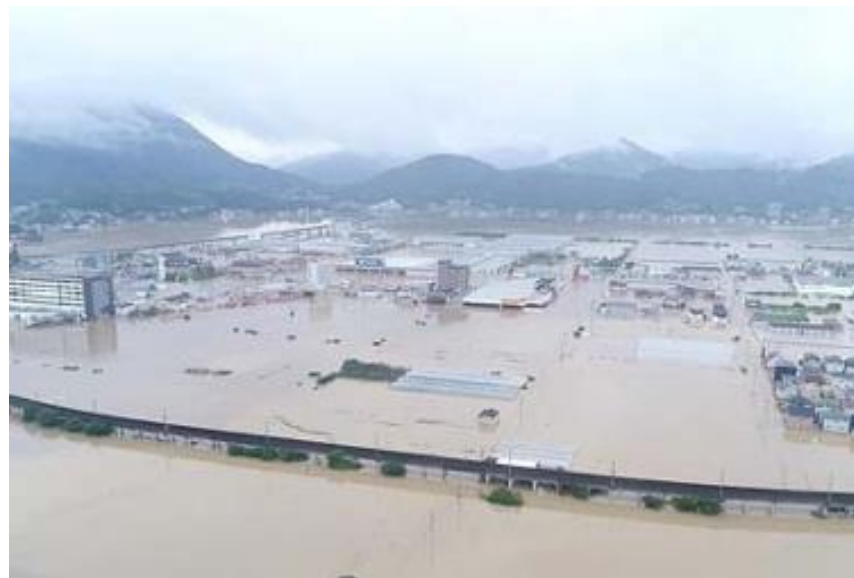
図4-5 平成30年7月東大洲地区浸水状況
