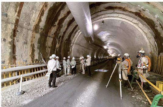
(仮排水トンネル工事現場)
