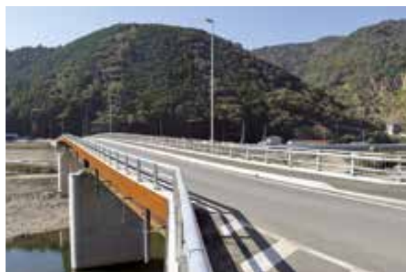
市道貫小屋線「父橋」が開通しました。
