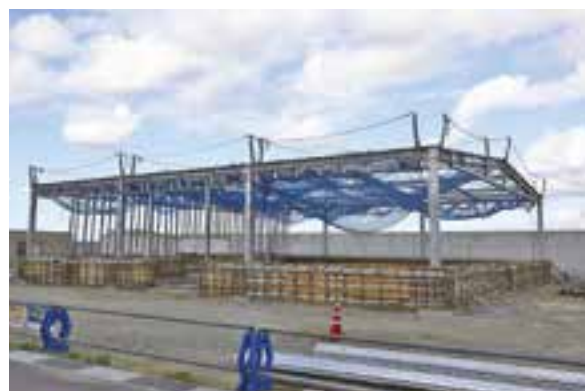
長浜港小型船だまりに畜養施設を建設しています。
