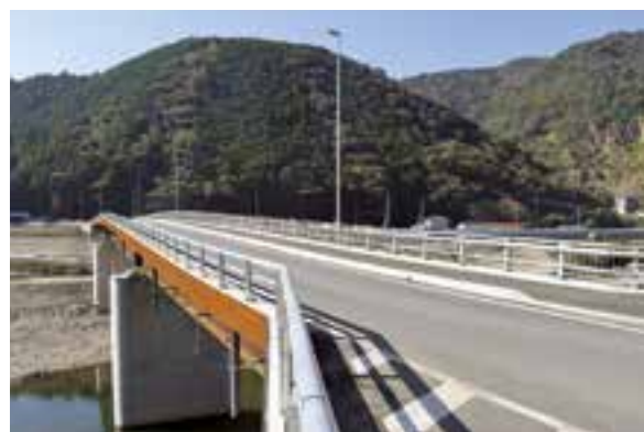
市道貫小屋線「父橋」が開通しました。
