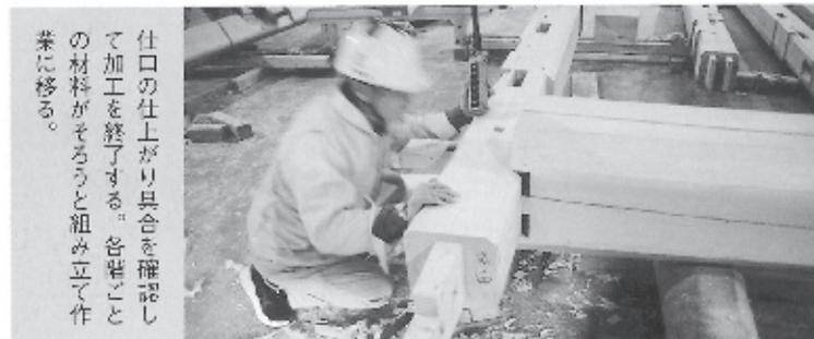
仕口の仕上がり具合を確認して加工を終了する。各部分の材料がそろうと組み立て作業に移る。
