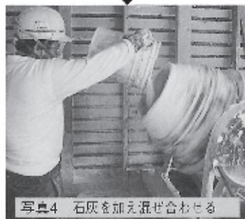
写真4 石灰を加え混ぜ合わせる
