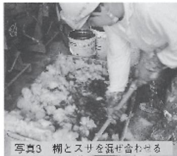
写真3 糊とスサを混ぜ合わせる
