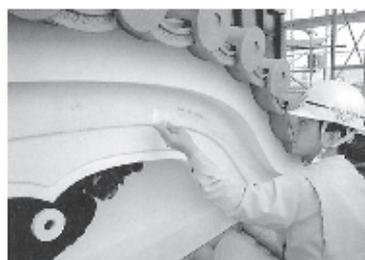
天守三層に載る唐破風は最も苦勞した部分。唐破風の曲線を造り出すために型板を作成した。
