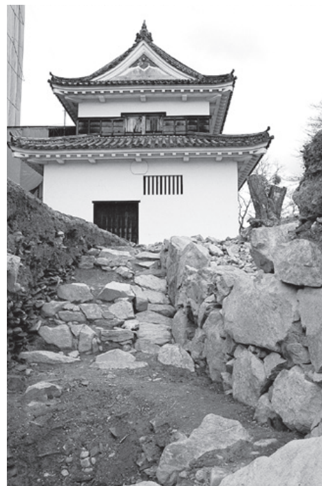
第十五図 暗り門検出状況（台所櫓前部分）
