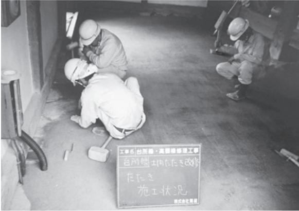
台所 土間たたき 打替え施工状況
