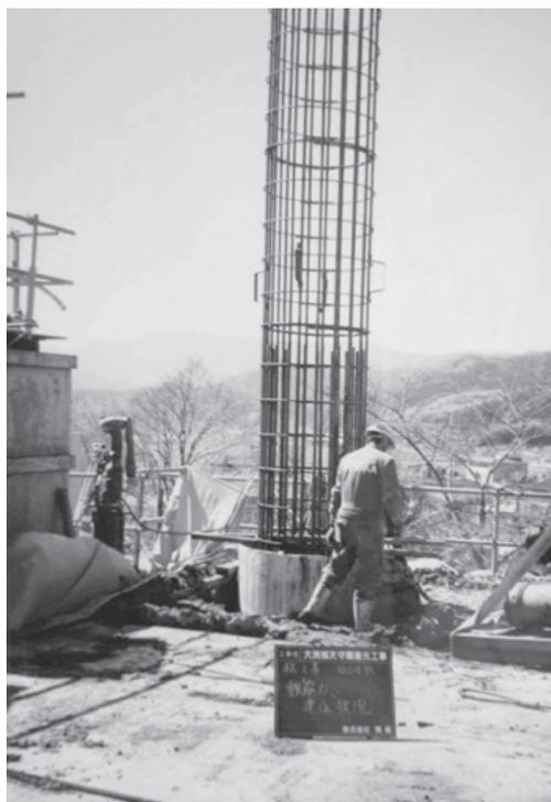
天守 機械併用深礎杭 鉄筋籠吊込作業状況
