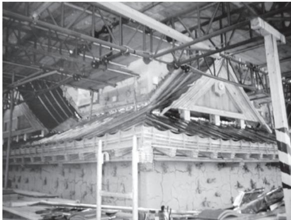
屋根土居葺銅板 施工状況
