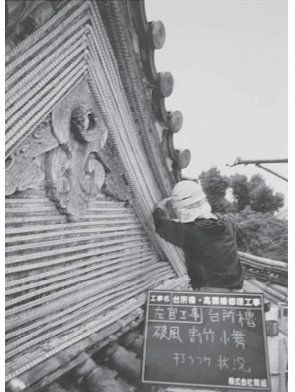
台所櫓 二層入母屋破風 割竹小舞取付け状況
