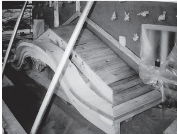
天守 唐破風懸魚・妻壁板取付け完了
