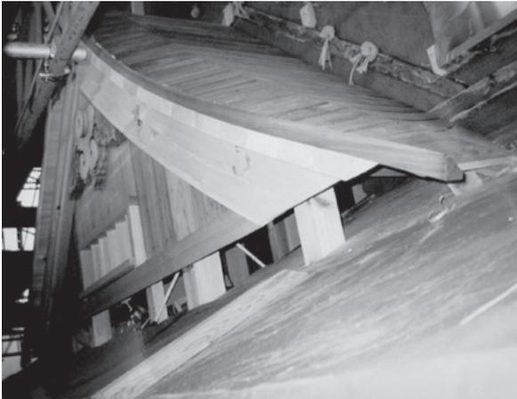
天守 大千鳥破風懸魚・妻壁板取付け完了
