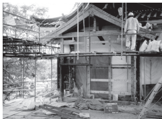
北多聞櫓解体作業状況
