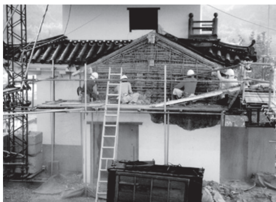
西多聞櫓解体作業状況
