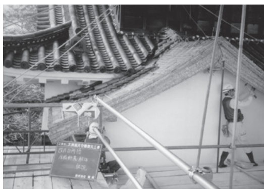
北多聞櫓解体作業状況
