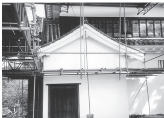
北多聞櫓解体前状況
