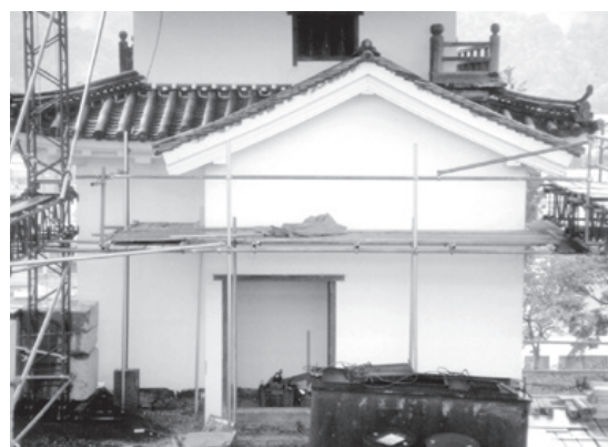
西多聞櫓解体前状況
