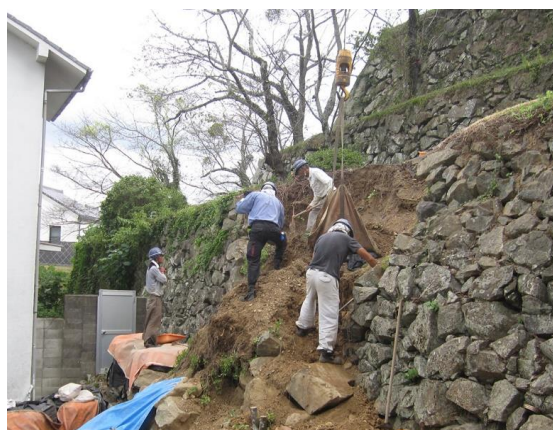
石垣D-1箇所崩落部の土砂撤去の様子 (令和5年6月27日)
