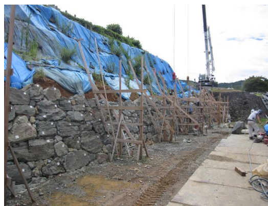
石垣A-2箇所の石垣積み直し工事の様子 (令和5年8月27日)
