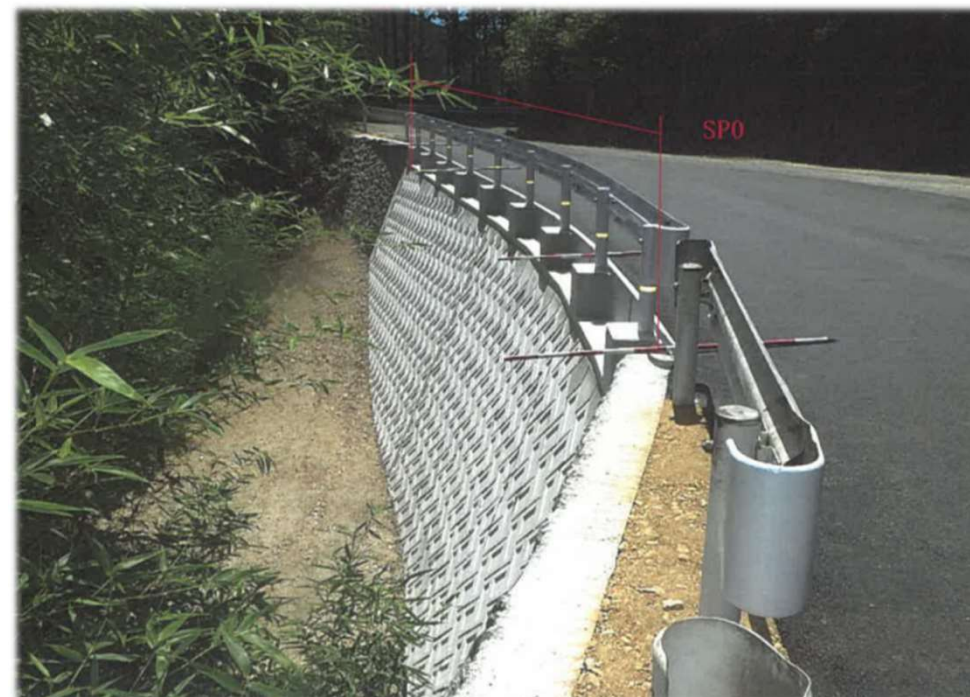
市債を活用し復旧した市道
