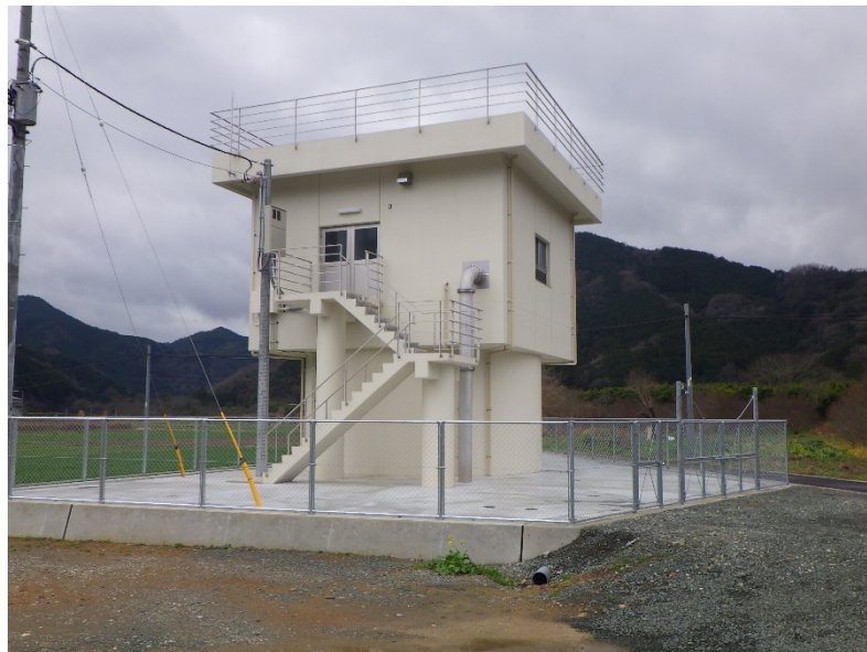
大洲市上水道 村島水源地
