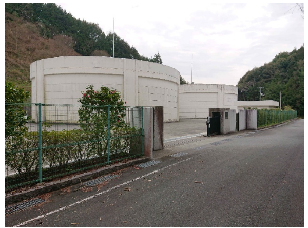
大洲市上水道 五郎配水池
