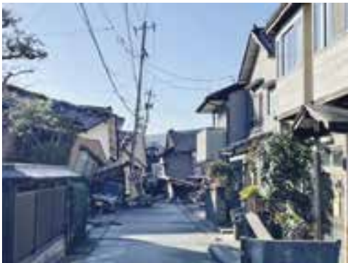
能登半島地震でも古い家屋の倒壊が目立つ (被災地派遣職員による撮影)
