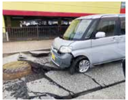
被災地ではマンホールが隆起した光景が多くみられた（被災地派遣職員による撮影）
