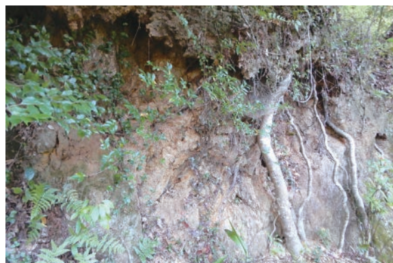
〔写真 4-9〕 崖地の岩盤風化の状況
