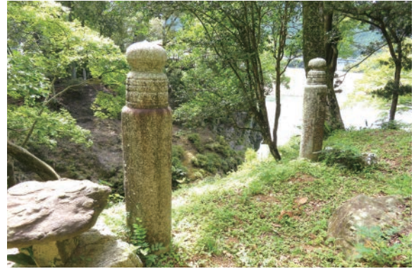
[写真 3-18] 藤雲橋の親柱（主庭側）
