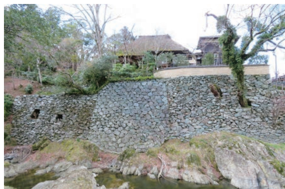
〔写真 3-50〕 崖地及び石垣 石垣
