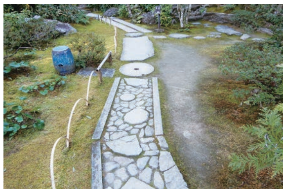
〔写真 4-1〕排水不良、地被類の衰退の状況
