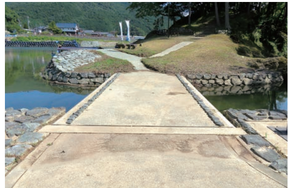
[写真 3-53] 崖地及び石垣 渡河橋
