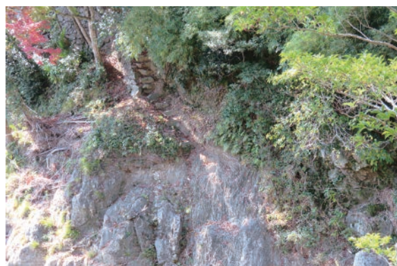
〔写真 4-11〕 土砂堆積の状況
