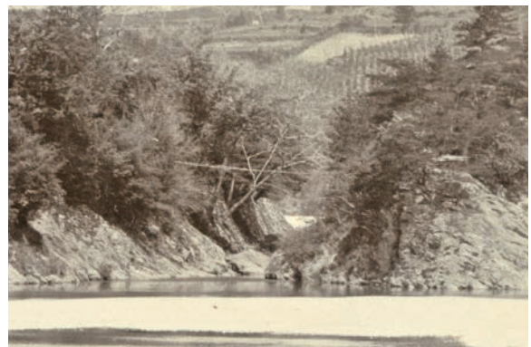
〔史料 4-1〕 藤雲橋の架線 （古写真部分拡大 大正2年～昭和5年）
