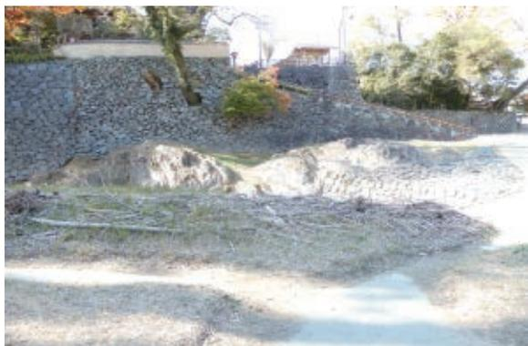
[写真 4-18] 護岸の流木竹や土砂堆積の状況
