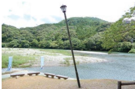
[写真 4-32] 照明の傾倒
