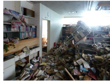
(被災直後の図書館脇川分館内)
