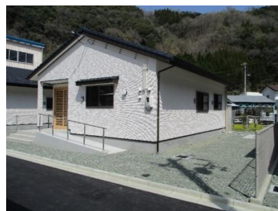
(災害公営住宅(下鹿野川団地))
