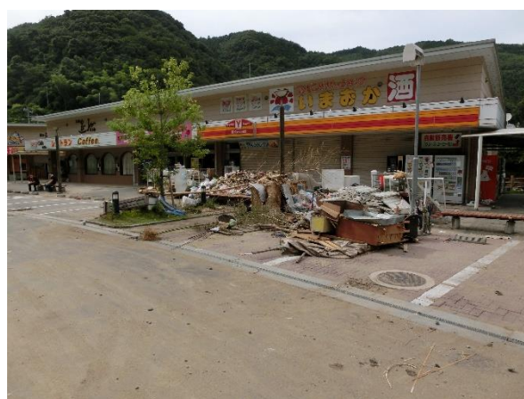
(被災後の肱川商業集積施設)
