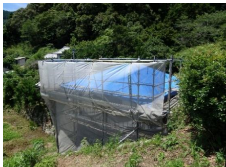
古学堂跡文庫保存修理の様子 (令和4年6月18日)
