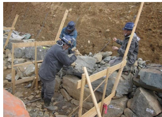
石垣A-2箇所での石垣積み直し工事の様子 (令和5年2月15日)
