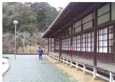
消防署による市内指定文化財建造物の点検 (令和5年1月23日)
