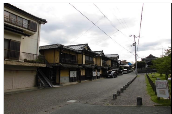
地下埋設予定電線②
