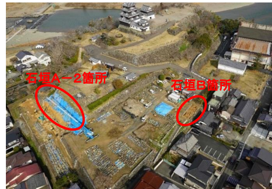
石垣A-2箇所と石垣B箇所の様子 (令和5年2月2日)
