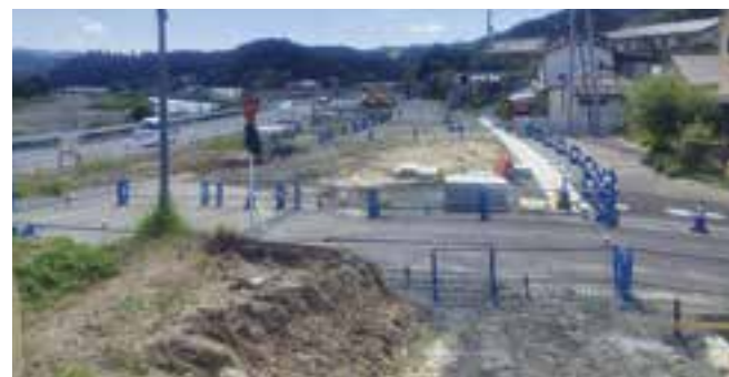
玉川地区の水道移設工事
