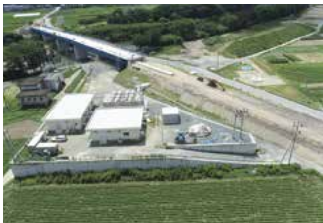
工事中の菅田浄水場
