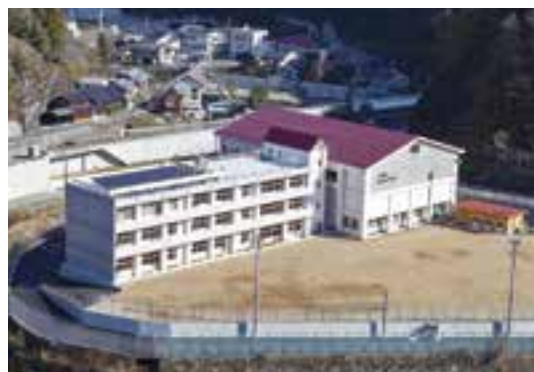
令和5年2月に完成した胨川中学校の校舎と体育館
