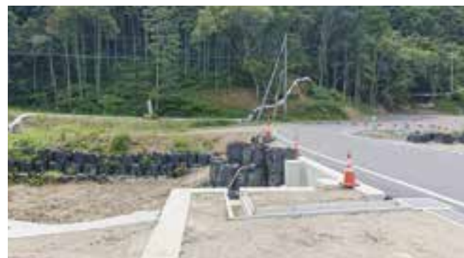
小倉地区の水道移設工事
