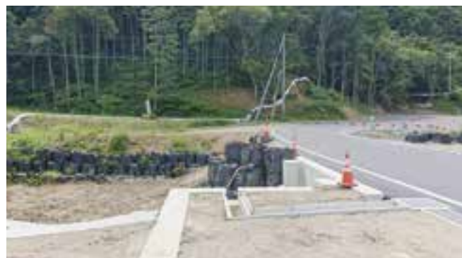
小倉地区の水道移設工事
