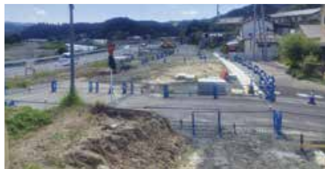
玉川地区の水道移設工事
