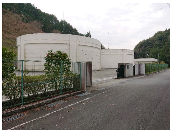
大洲市上水道 五郎配水池
