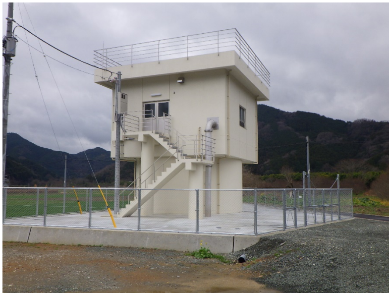
大洲市上水道 村島水源地
