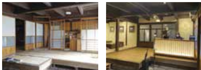
古民家の改修事例（左：改修前 右：改修後）
