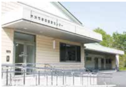
大洲市学校給食センター
