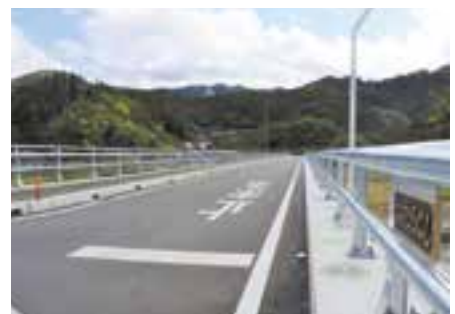
令和4年6月に完成した大成橋
