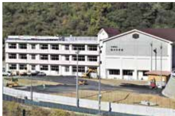
完成間近になった肱川中学校の校舎と体育館 (令和4年11月12日現在)
