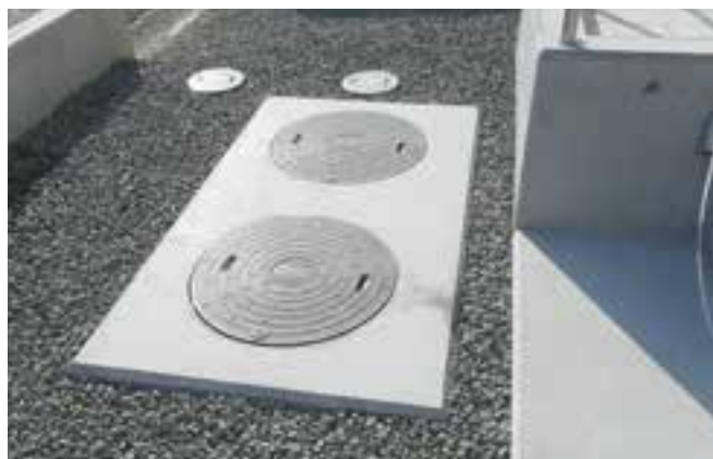
(合併処理浄化槽の設置状況)
