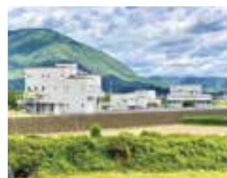
肱北浄化センター
