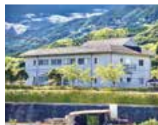
肱南浄化センター
