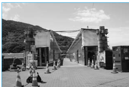
工事中の長浜大橋②
