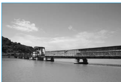
工事中の長浜大橋①
