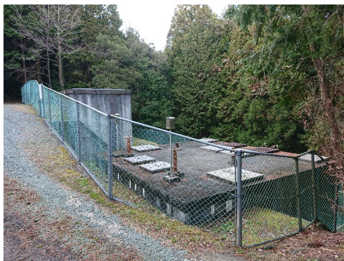
保子野簡易水道 浄水場
