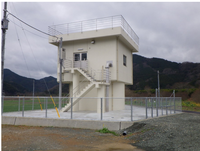
大洲市上水道 村島水源地
