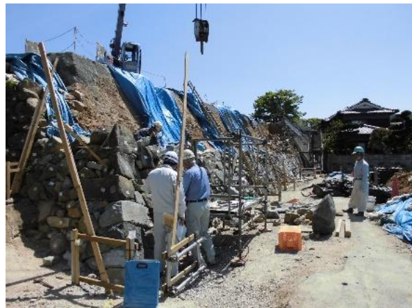
大洲城の石垣改修工事の様子
