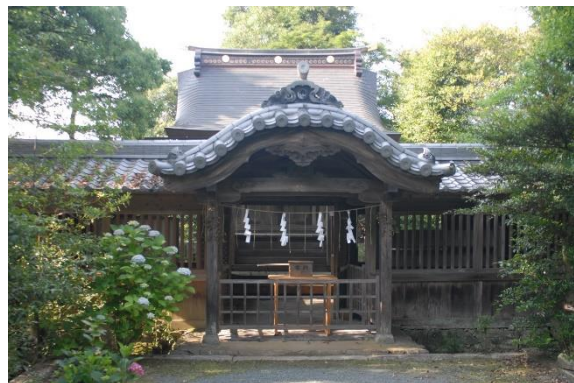
八幡神社境内に造営された三祖社
