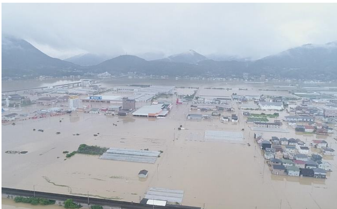
洪水により浸水した大洲盆地 (平成 30 年 (2018) 7 月 7 日)
