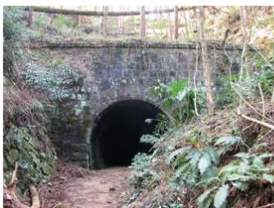
切石と煉瓦造りの河内トンネル
