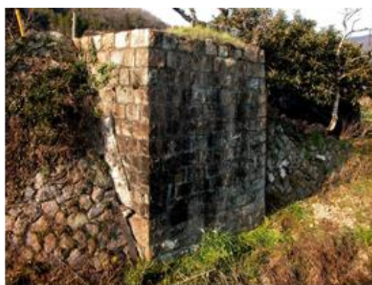
切石造りの橋台
