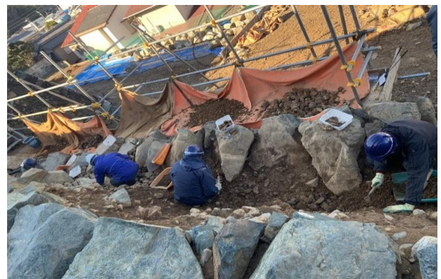
石垣解体・発掘調査の様子 (令和4年1月21日)
