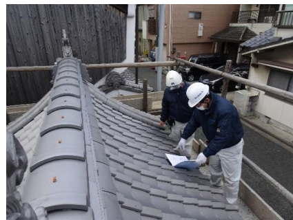
旧末永家住宅正門等修理の様子 (令和4年1月13日)
