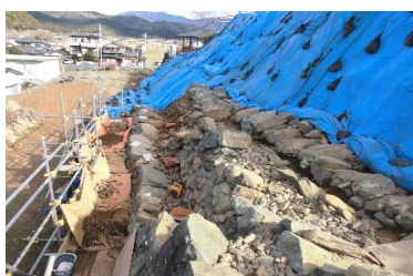
改修中の大洲城の石垣 (石垣A-2箇所)
