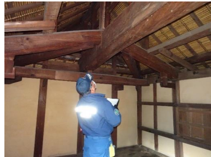
消防署による市内指定文化財建造物の点検 (令和4年1月27日)
