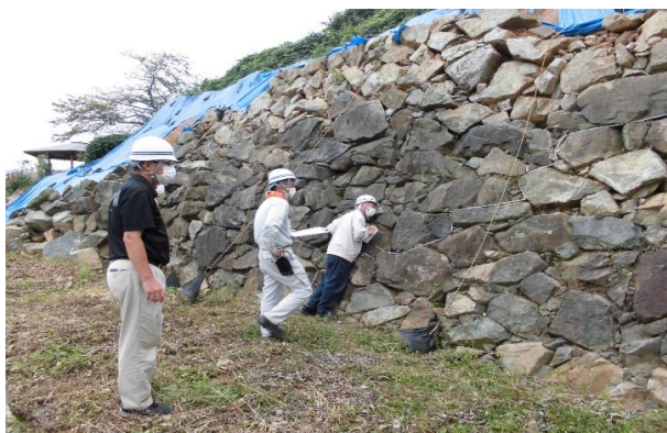
石垣保存修復委員会委員による状況確認 (令和3年9月7日)
