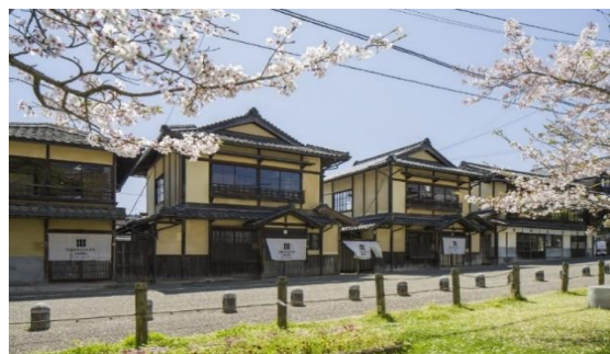
古民家のリノベーションによる活用
