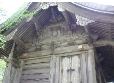
「八幡神社本殿」火災報知器の設置 (令和3年12月1日)
