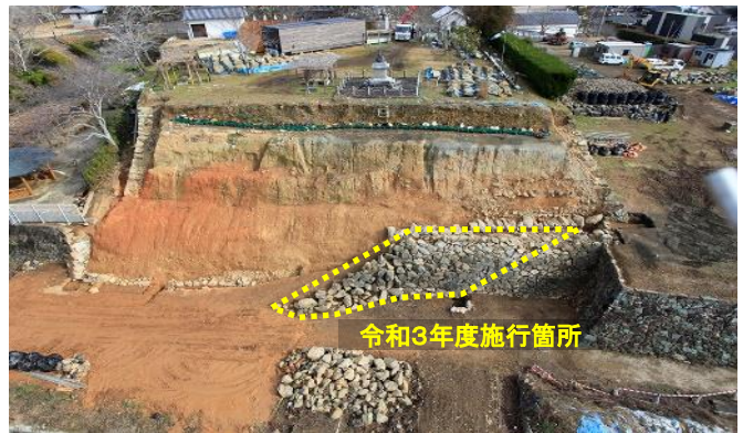
石垣(A-2)箇所全景
