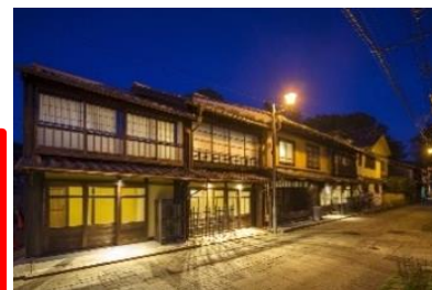
町家をリノベーションした宿泊施設
