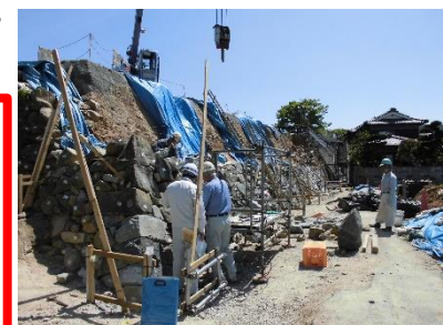
石垣積み直し工事の様子
