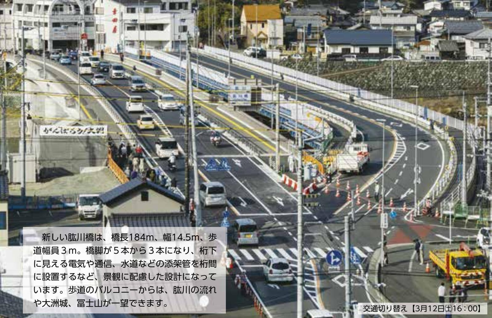
新しい肱川橋は、橋長184m、幅14.5m、歩道幅員3m。橋脚が5本から3本になり、桁下に見える電気や通信、水道などの添架管を桁間に設置するなど、景観に配慮した設計になっています。歩道のバルコニーからは、肱川の流れや大洲城、富士山が一望できます。
