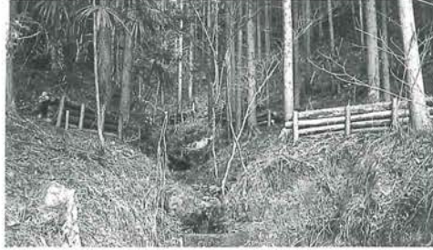
重要水源地域保安林整備事業 （予子林・大谷地域の小川整備）13ha
