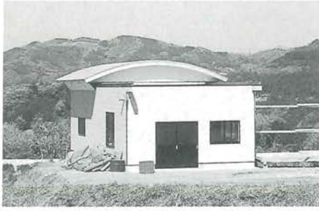
ドーム型の屋根がスライドする 「正山星の観測所」
