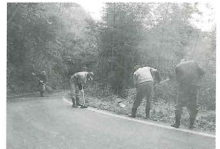
獅子淵周辺の遊歩道の整備
