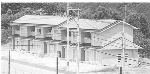
鹿野川第2団地に設置した太陽電池
